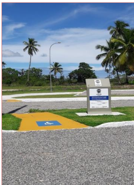
FOTO 8 - Rampa de acesso instalada em pista forrada com brita
