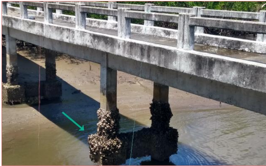
FOTO 3 - Passarela do Porto dos Cavalos em Estância/SE
