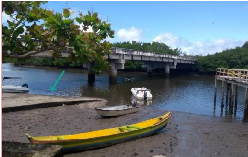
FOTO 1 - Rampa improvisada no Porto de N'Angola
